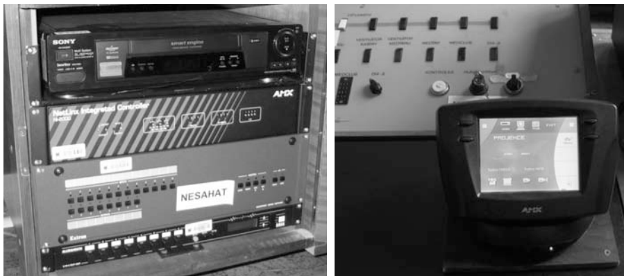
Obrázek 3: Video, řídicí systém a dotykový ovládací panel v posluchárně Fyziologického ústavu LF MU v areálu Komenského 2.
